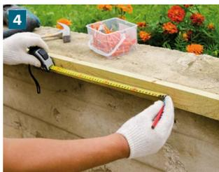
Используйте дюбель-гвоздь длиной минимум 70 мм. Шаг крепления по горизонтали 400 мм, по вертикали 300 мм.
