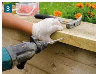
Для устройства обрешетки используйте бруски сечением 20\*40 мм и влажностью не более 20%. Установите горизонтальную и вертикальную обрешетку.
