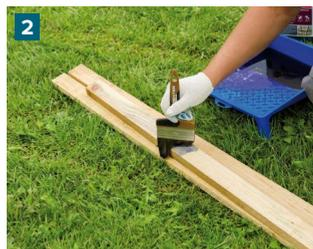
Перед установкой обрешетки обработайте бруски антисептиком для древесины. Наносите его в 2-3 слоя с промежуточными сушками 20-30 минут. При погружении выдержите 5-10 минут.
