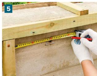
Шаг установки вертикальной обрешетки – 300 мм.
